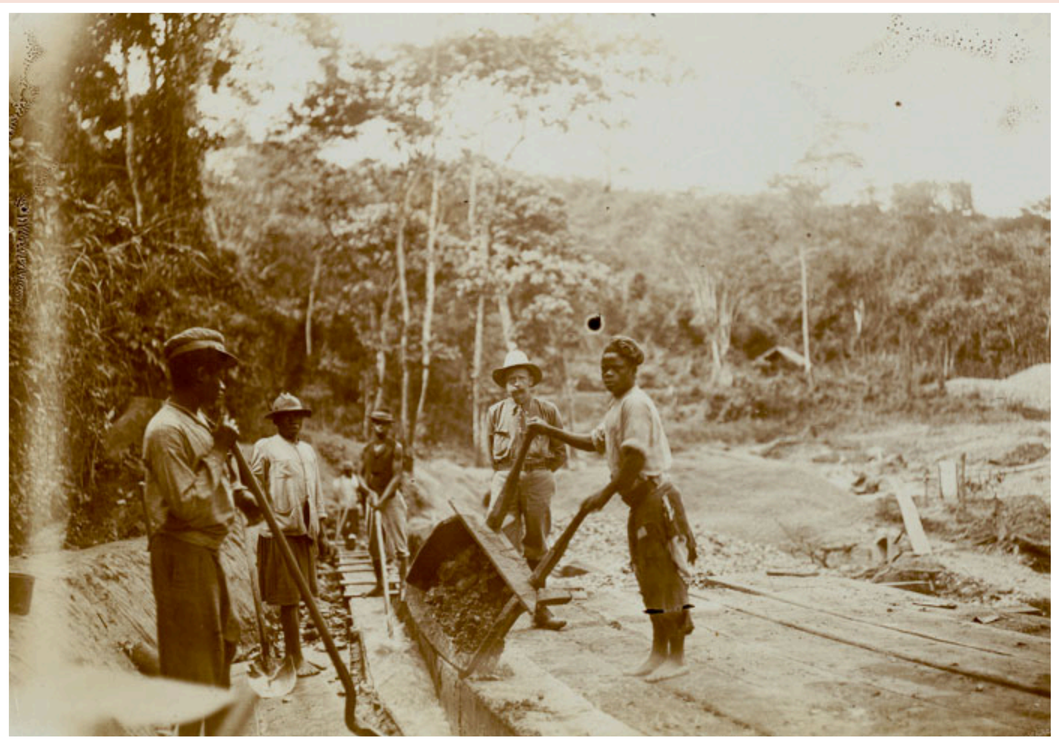
Quatre ouvriers et un surveillant lors de la construction d'une ligne de chemin de fer, (photographie) s.d. AGR, Archives Hubert Droogmans, n° 268. http://www.expocongo.be/
